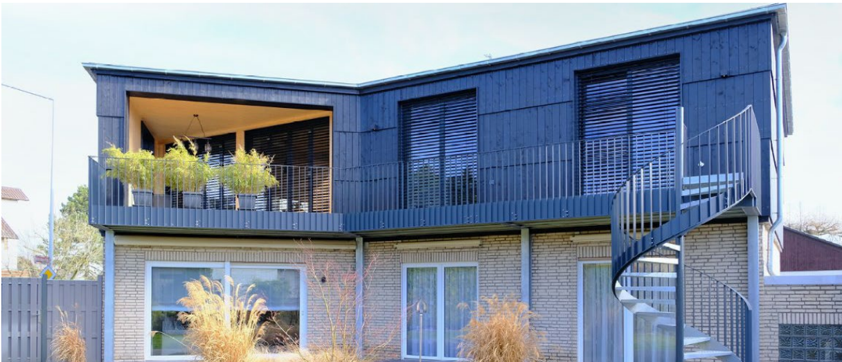
Umbau eines Einfamilienhauses © Perka Architekten
