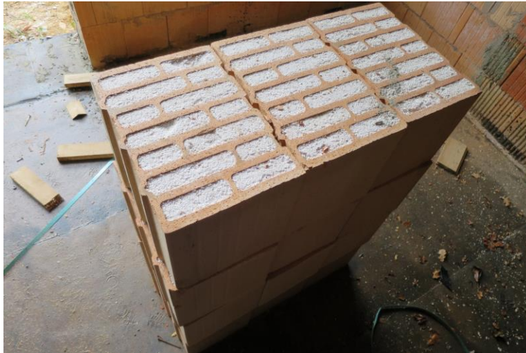
Gedämmter Porotonstein T9
