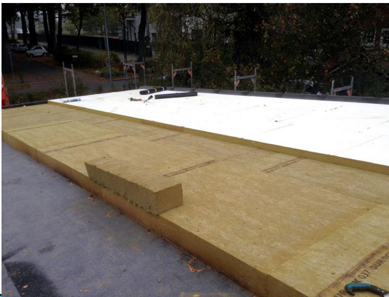
Verlegung Dachdämmung
