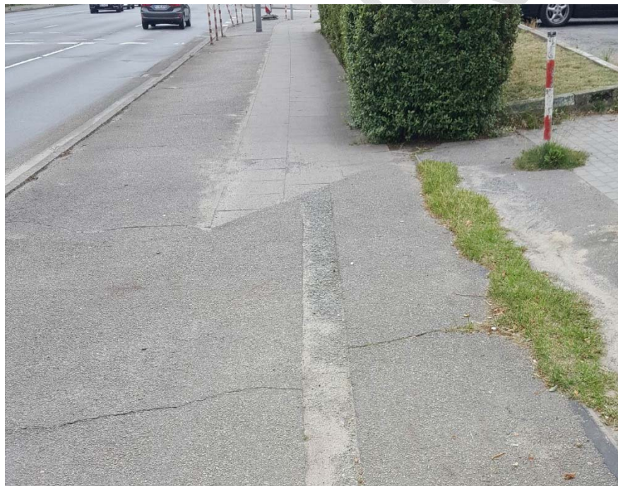
Abbildung 7: Getrennter Fuß- und Radweg an der Altonaer Chaussee (südl. Seite)
