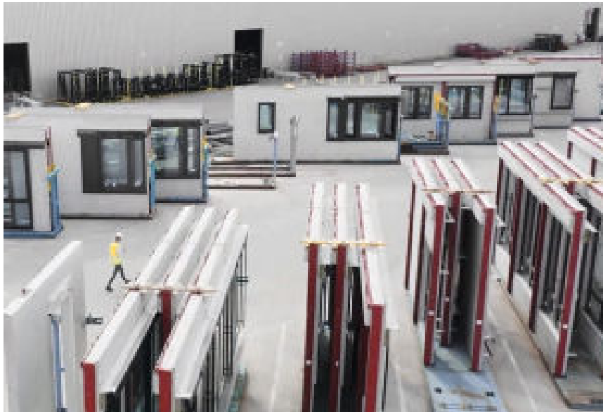
Erweiterung Schulzentrum Schenefeld „Achter de Weiden“
