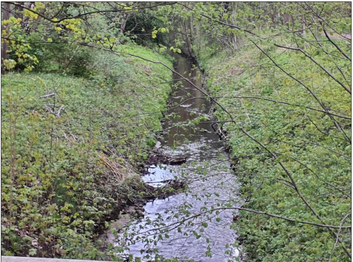
Düpenau, naturfern ausgebautes Regelprofil
