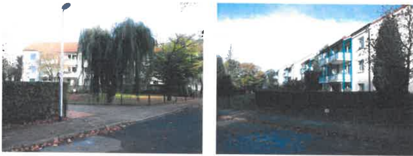
Bestehender Geschoss- wohnungsbau
